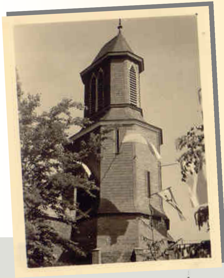
1933: Bau des neuen Kirchturms
